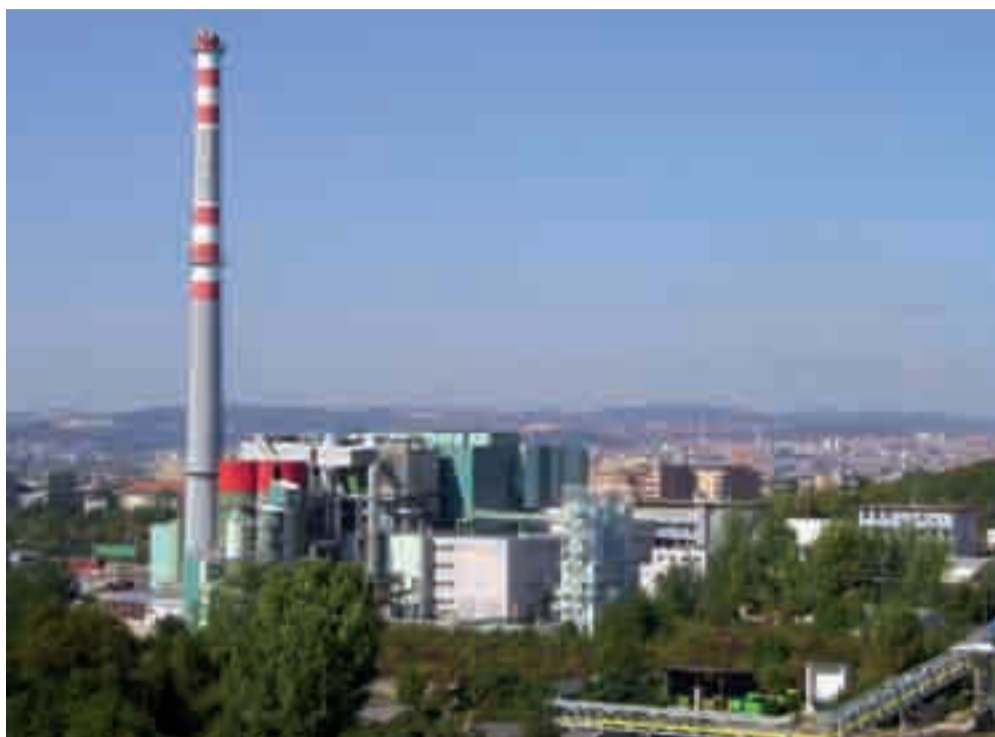
Zařízení na energetické využívání odpadu
